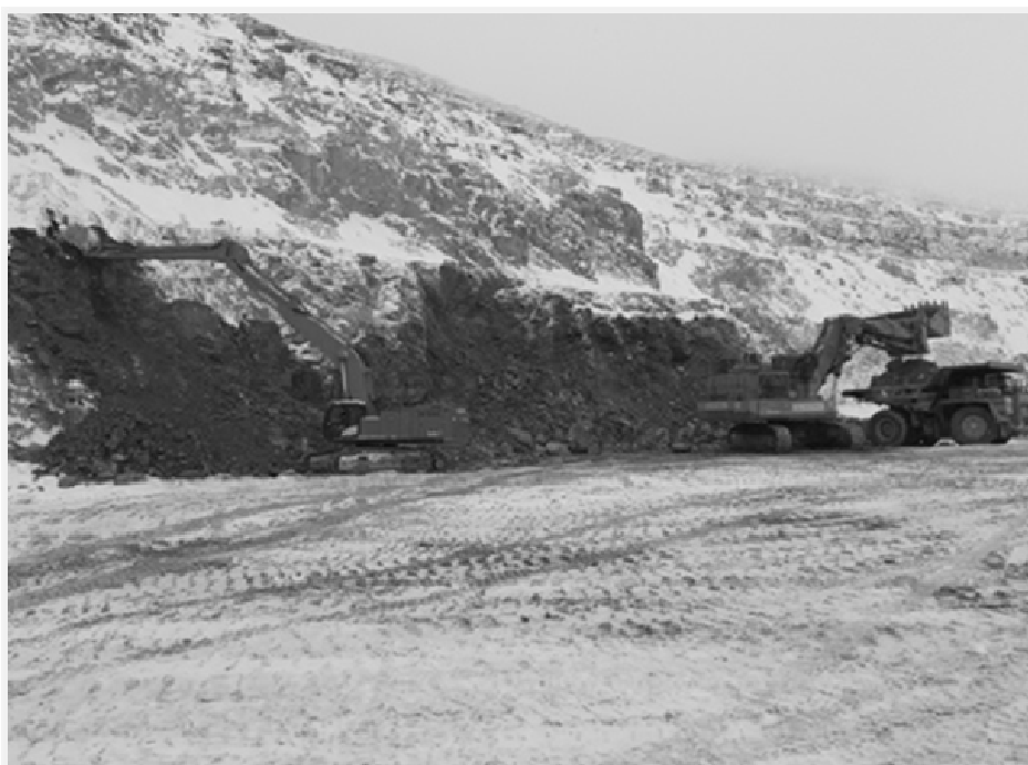
Фиг.2 Момент от технологичния процес при оформяне на стъпало (подстъпало)
