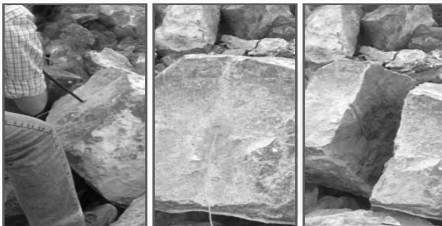
Фиг. 6. Гладко разцепване на камък с ниско-скоростен заряд.
