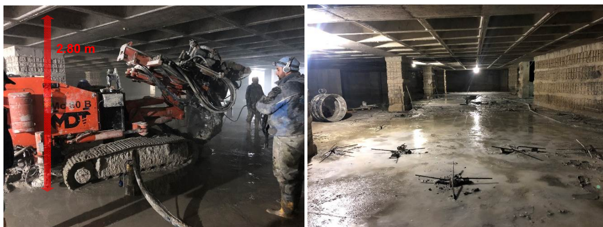
Фиг. 10 Изпълнение на комплексен метод за подобряване параметрите на земната основа и усилване на фундаментната конструкция чрез прилагане на технология „джет-граутинг“ – сграда в град Бургас
