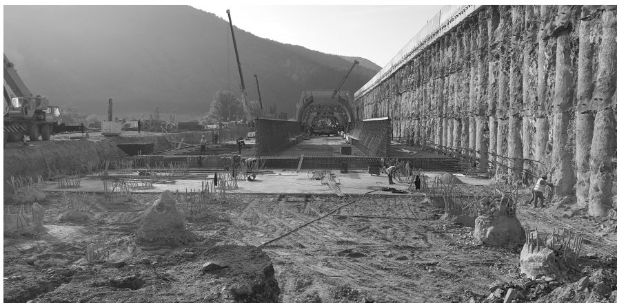
Фиг.4: Предпазна стена и изпълнение на фундаментна плоча
