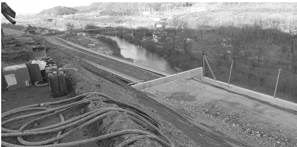
Фиг.6: Етап от изпълнението на армирания насип по откоса
