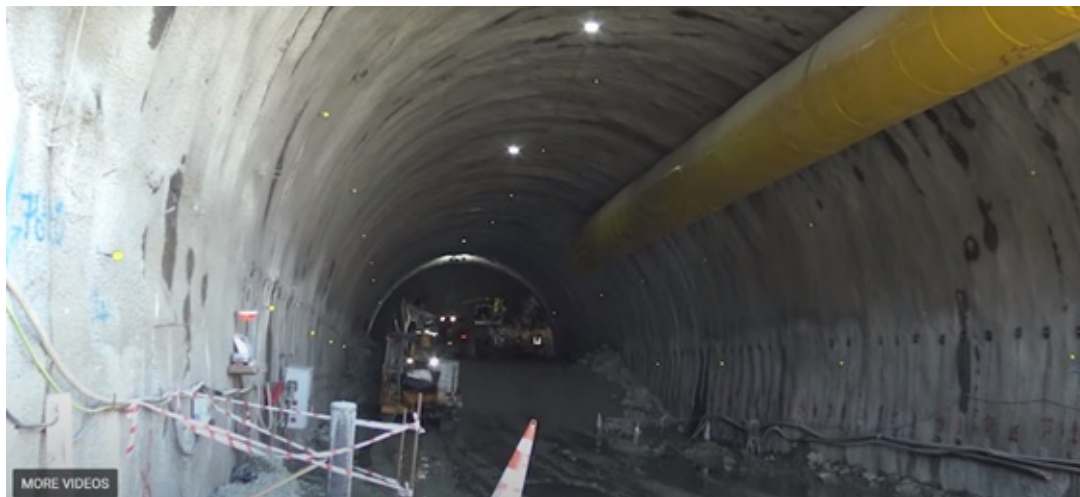
Фиг. 9. Точка от полигоновата мрежа и част от наблюдаваните точки в Тунел 11
